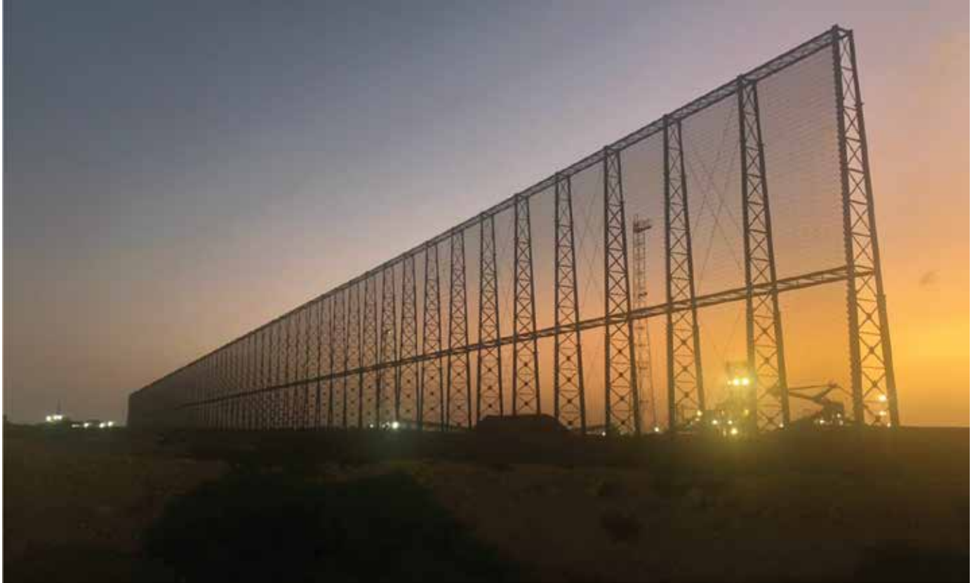
BARRERAS CORTAVIENTOS (CLIENTE CARBONES DEL CERREJÓN):
