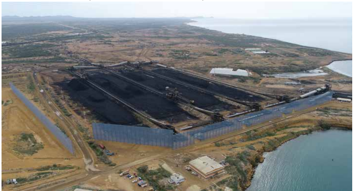
BARRERAS CORTAVIENTOS (CLIENTE CARBONES DEL CERREJÓN):
