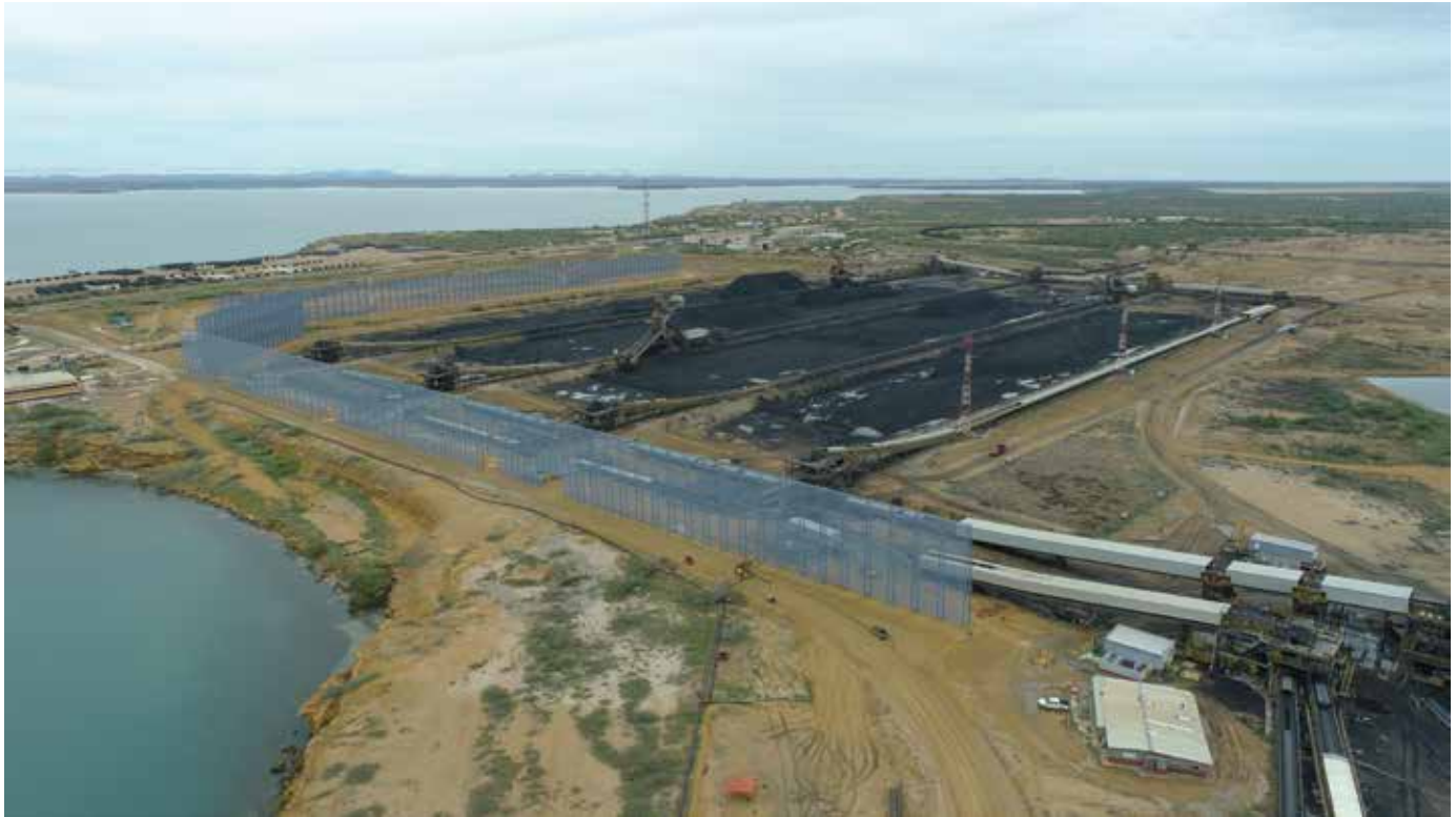
BARRERAS CORTAVIENTOS (CLIENTE CARBONES DEL CERREJÓN):
